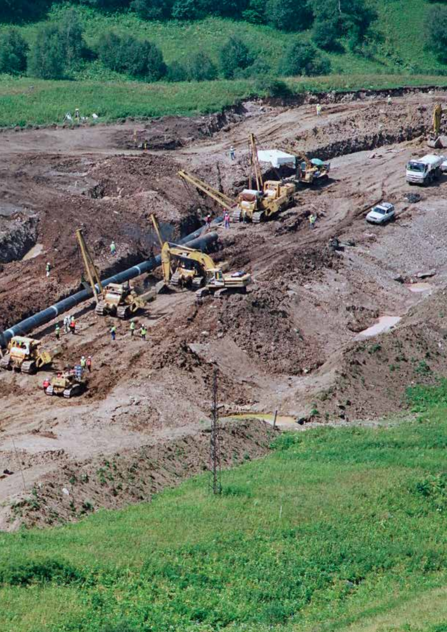
The pipeline construction activities. მილსადენის მშენებლობა.
